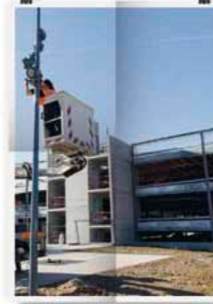
Le parking aérien du Pôle gare de Dreux
