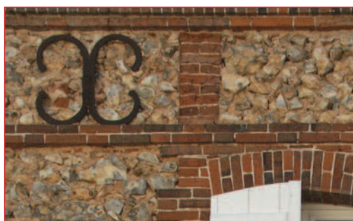
Maçonnerie de brique et silex.
