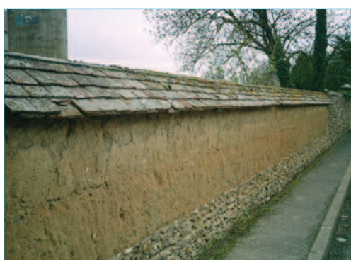
Mur en terre crue, soubassement silex. Broué.
