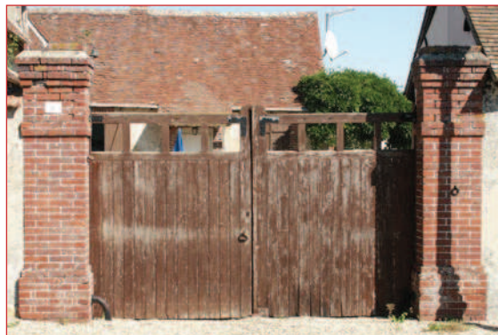
Portail avec piliers en brique. Tremblay-les-Villages
