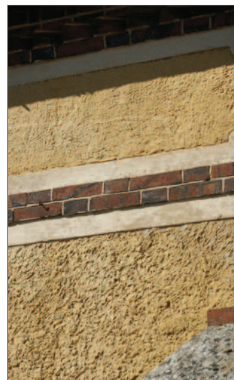
Enduit couvrant ocre-jaune et brique.
