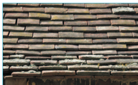
Toit débordant en tuile
