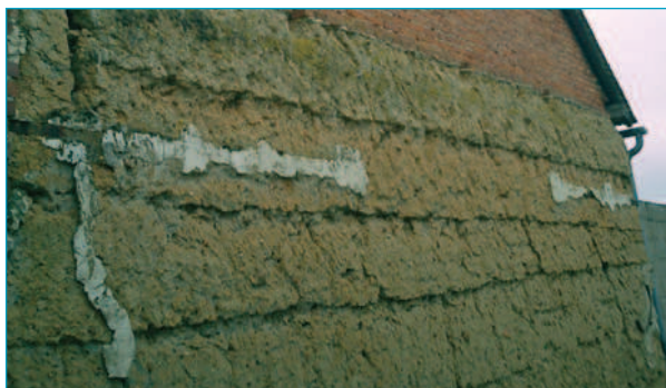
Mur en bauge. Broué.
