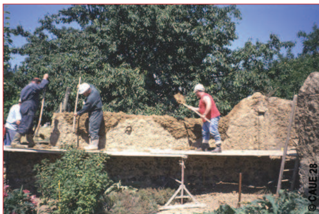
Chantier de reconstitution d'un mur en bauge. Au dessus, talochage de la deuxième levée. En dessous, préparation pour la mise en oeuvre d'une levée supplémentaire.
