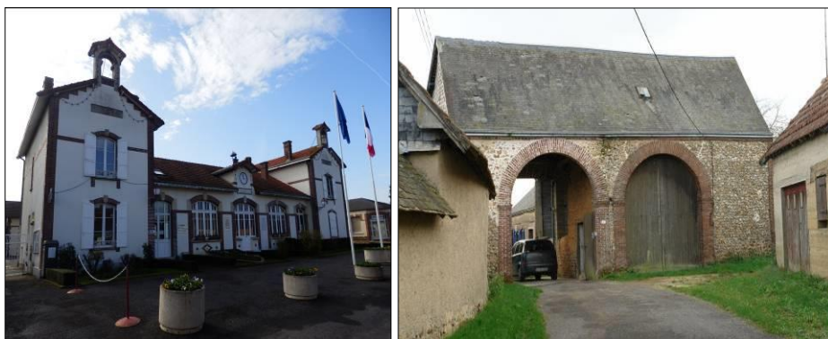
La Mairie (village de Tremblay-le-Vicomte), un corps de ferme à cour fermée dans le hameau de Moreaulieu (à droite) (source : Agglo du Pays de Dreux)
