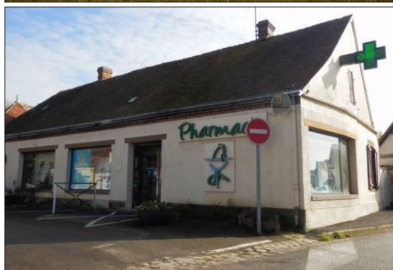
La zone d'activité de Pizoteau (en haut) et la pharmacie dans le village de Tremblay-le-Vicomte (en bas) (source : Agglo du Pays de Dreux)
