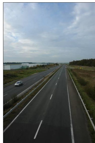
La RN 154, au niveau de la zone d'activité de la Vallée du Saule (source : Agglo du Pays de Dreux)
