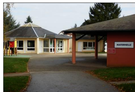
L'école maternelle et primaire de Tremblay-les-Villages (source : Agglo du Pays de Dreux)
