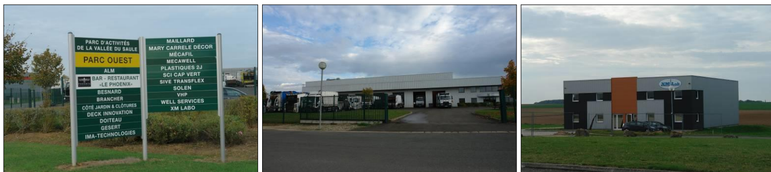
Des entreprises sur la zone Ouest du parc d'activités de la Vallée du Saule (source : Agglo du Pays de Dreux)
