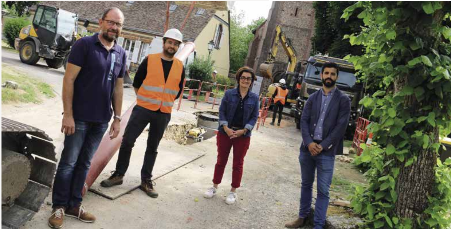
Les travaux lors de la phase 1, place de l'église (photo Agglo du Pays de Dreux)
